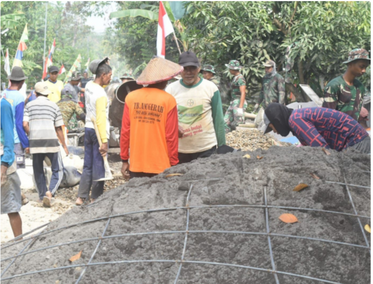
Pengerjaan Sasaran Fisik TMMD Reguler ke-114 Kodim 0716/Demak Membuat Betonisasi Jalan.
