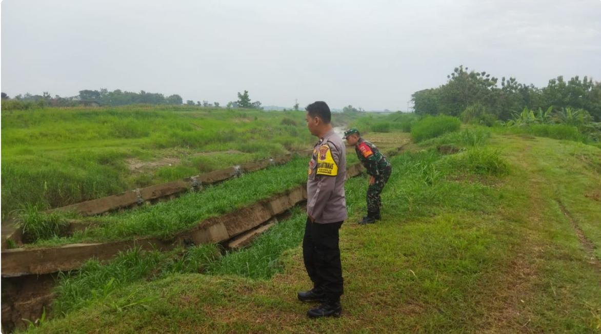
“Akan tetapi, akibat debit air sungai yang cukup banyak beberapa hari terakhir, membuat revetment retaining wall dan tanggul mengalami longsor sepanjang 60 meter,” ungkapnya.
